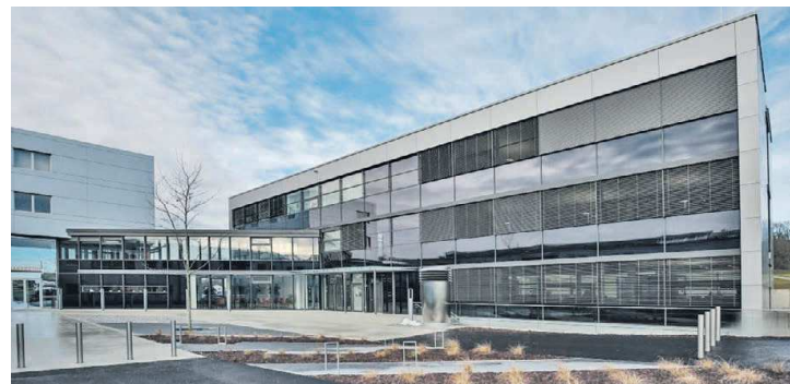
Nach kurzer Bauzeit wurde das neue Gebäude in Steyr im November 2018 von den BMD-Mitarbeitern bezogen.
