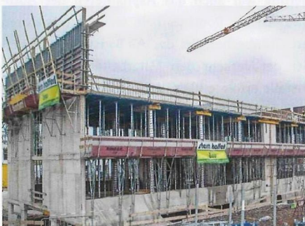
Arbeitssicherheit wird groß geschrieben, auch danke dem klugen Einsatz der Schalelemente.
